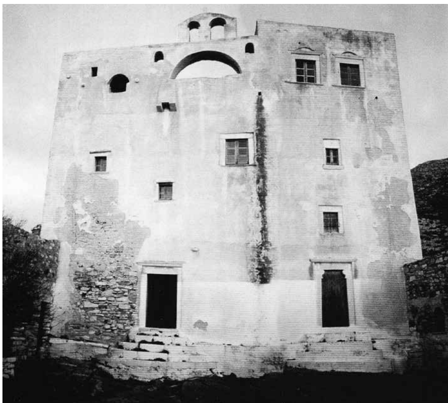
(εικ. 30) Η πρόσοψη του πύργου πριν την αποκατάσταση
