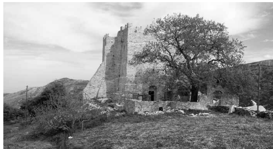
(εικ. 10) Η Μονή Φωτοδότη στον Δανακό (πηγή: MONUMENTA)
